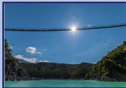
La passerelle de l'Ebron
